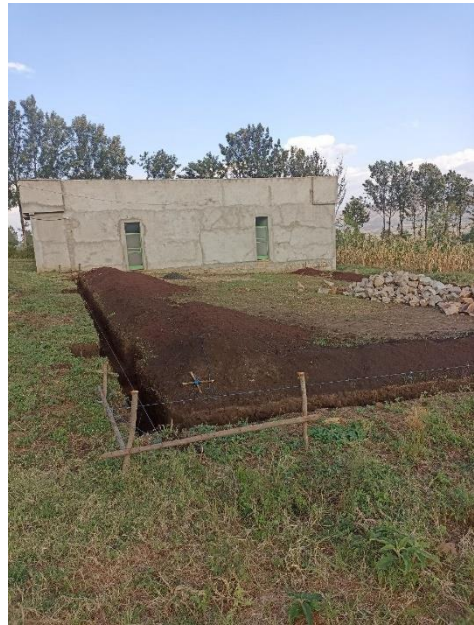
Der Bau der Halle ist in vollem Gange
