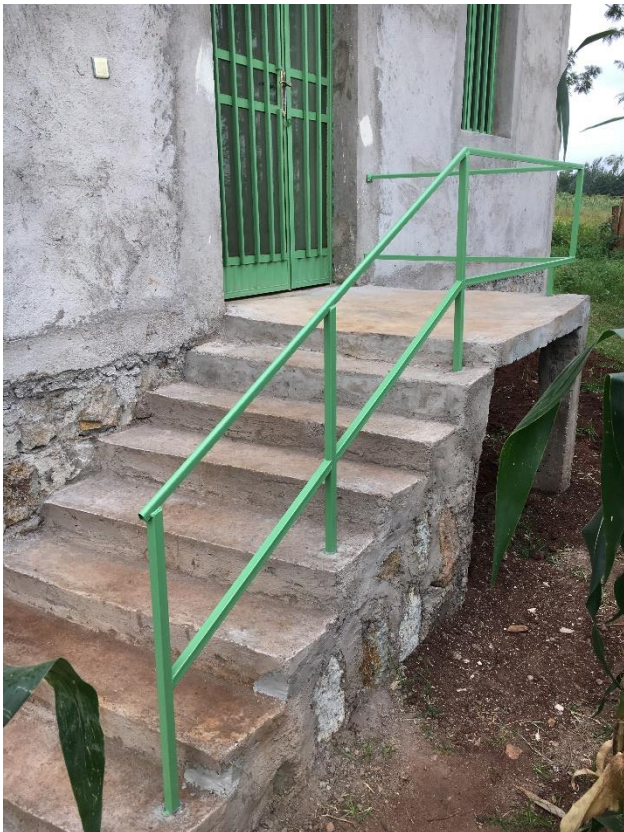
Treppe Haupteingang zum Gästehaus
